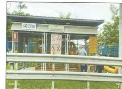
สถานีควบคุมแรงดันและวัดปริมาณก๊าซ
